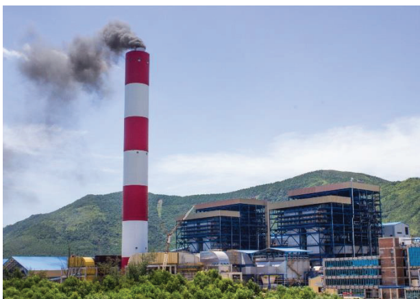
Hình d. Nhà máy nhiệt điện Vũng Áng 1
