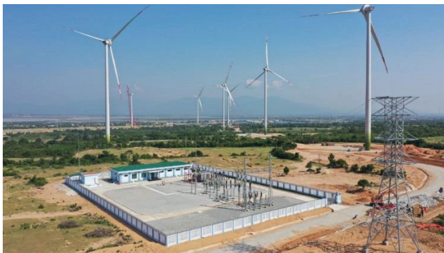
Hình 22: Nhà máy điện gió Ninh Thuận
