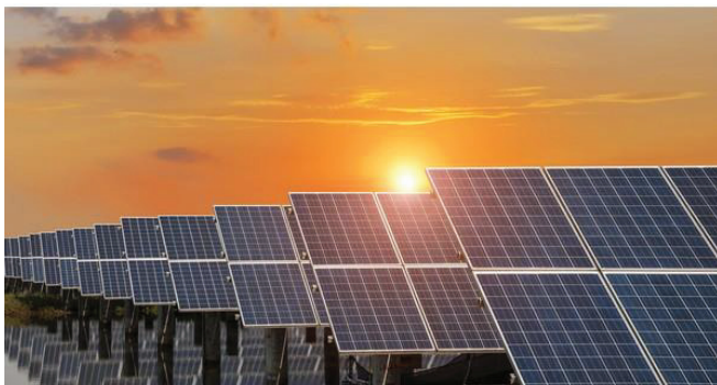
Hình 23: Nhà máy điện Mặt Trời
